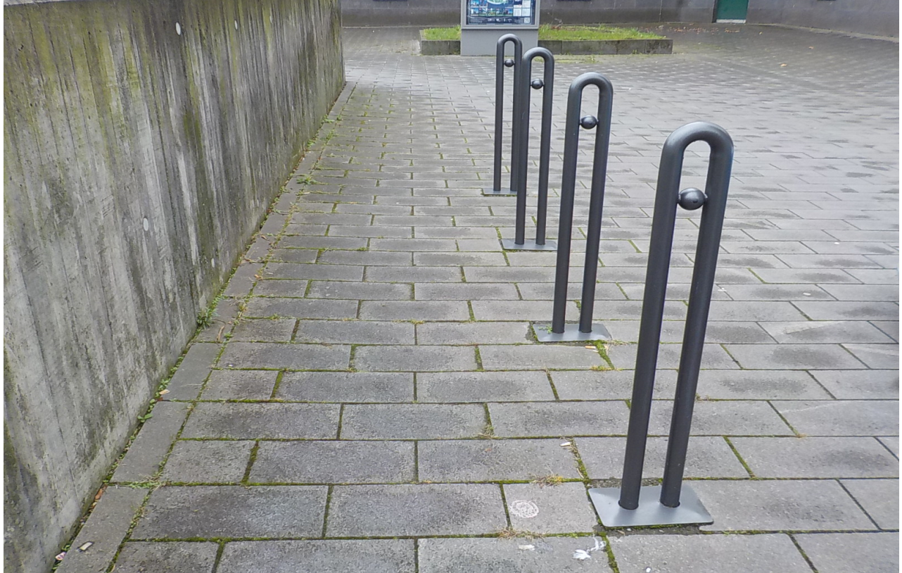
Bild 60: Sog. „Haarnadel“, feuerverzinkt und pulverbeschichtet DB 703, anthrazit, Länge 1250 mm, Höhe über Pflasterniveau 850 mm
