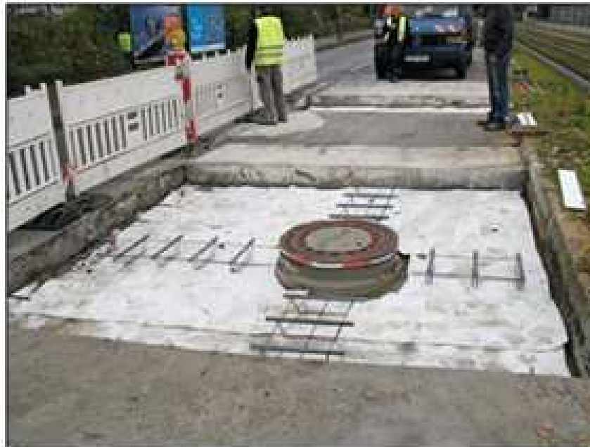
Bild 13: Beispiel einer Fugenanordnung am runden Schacht
