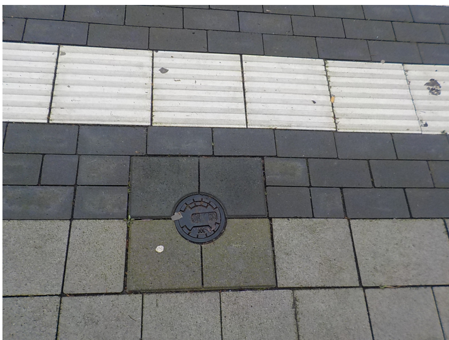
Bild 56: Umpflasterung von Kappen und Anschlüssen
