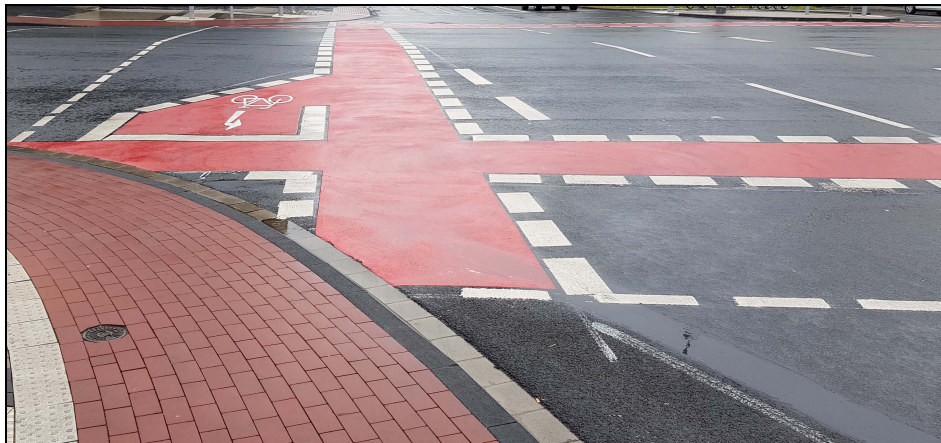
Bild 16: Rotbeschichtung in Knotenpunkten
