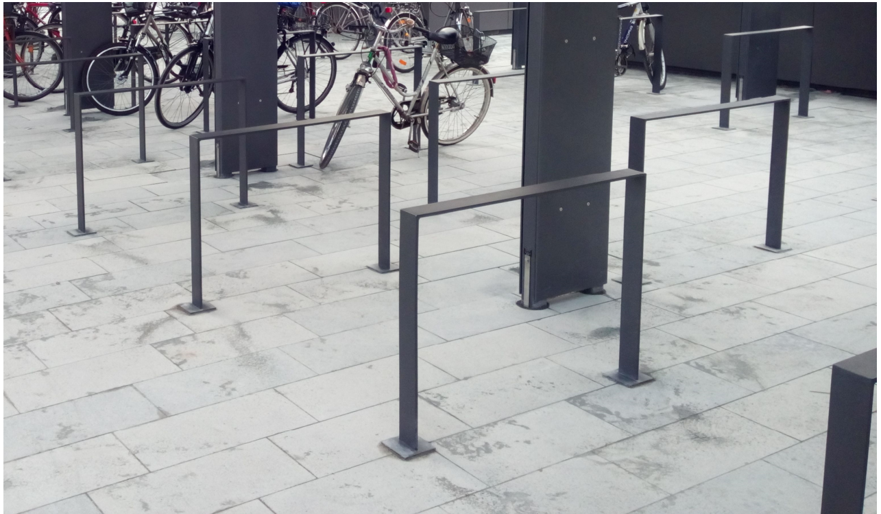
Bild 61: Fahrradanhänger, feuerverzinkt und pulverbeschichtet, anthrazit, Maße 1000 x 80 x 700 mm, Höhe über Pflasterniveau 700 mm
