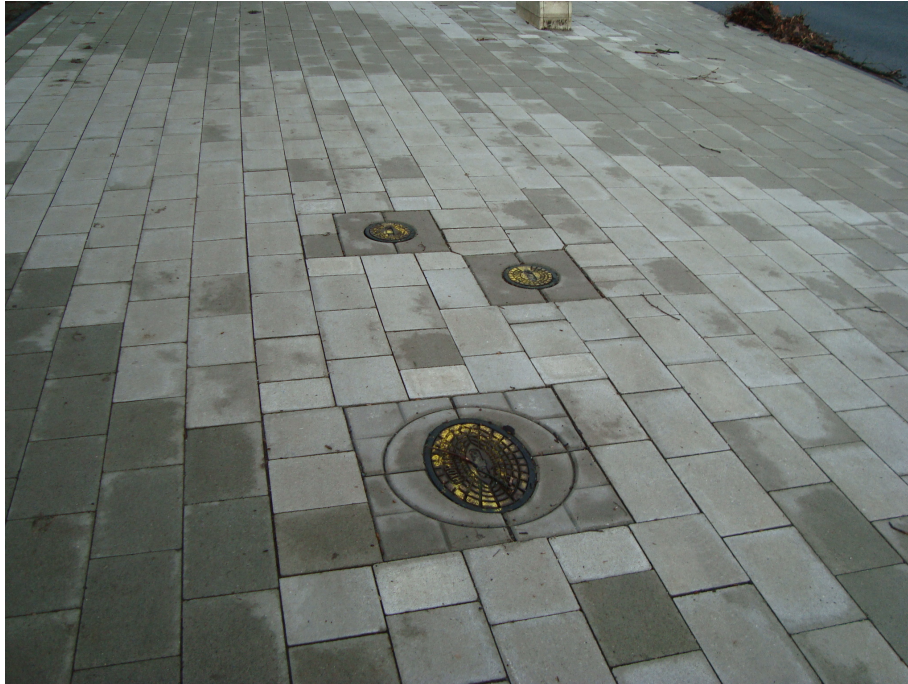
Bild 55: Umpflasterung von Kappen und Anschlüssen
