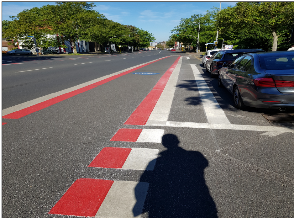
Bild 17: Rotbeschichtung auf der Strecke
