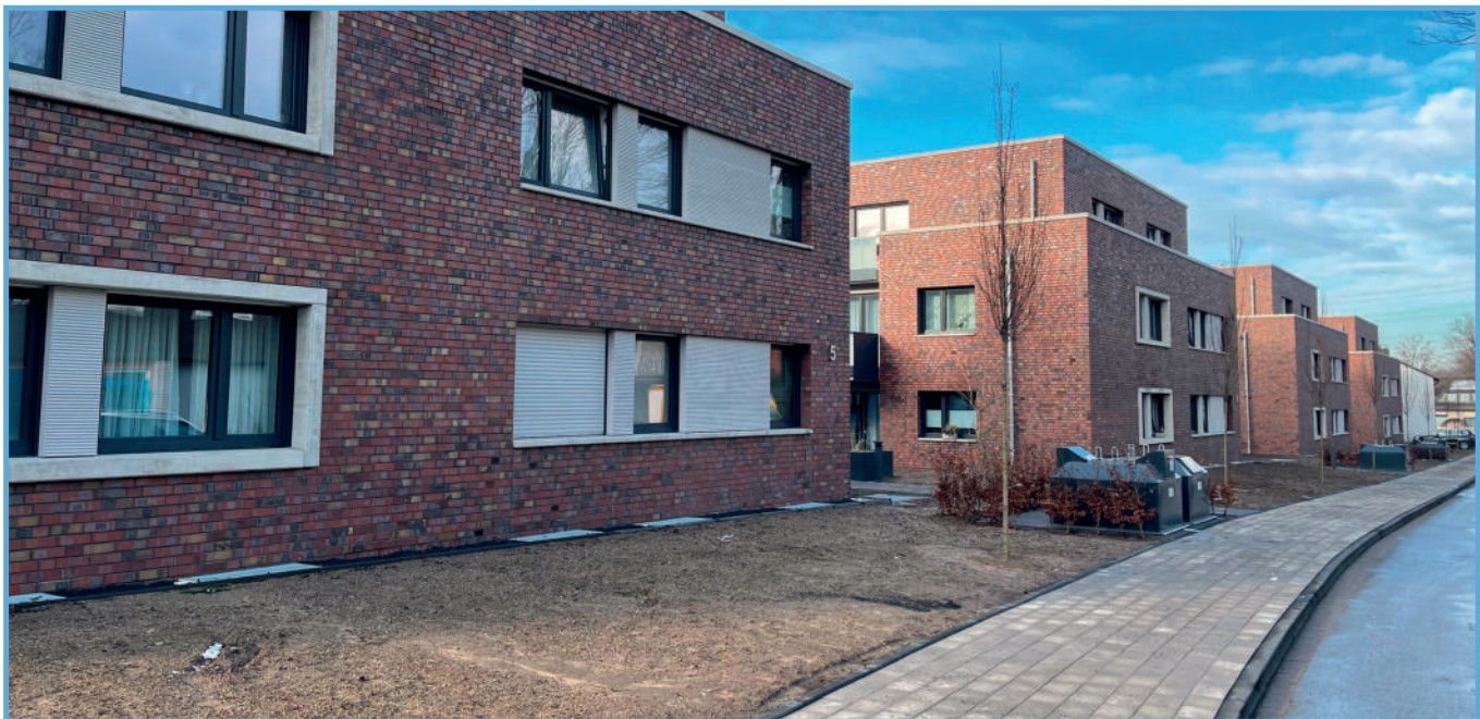
Abbildung 18: Baumaßnahme „Hettkampsweg“ im Ortsteil Röttgersbach
