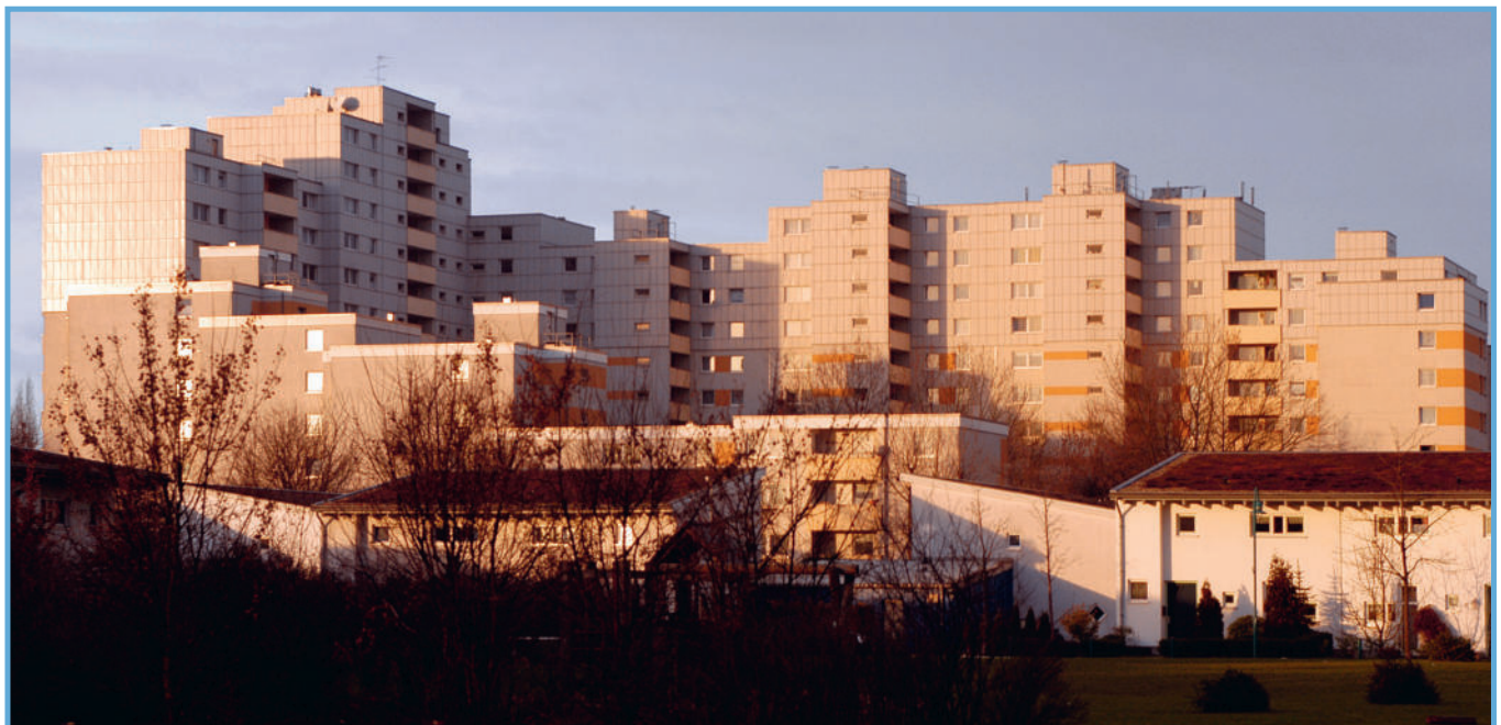
Abbildung 9: Wohnungsbestände im Quartier Hagenshof
