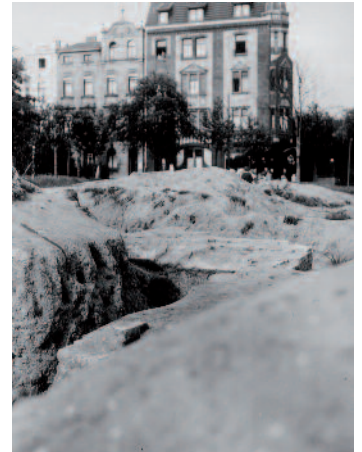
Mauern des Klosters in Duisern südlich des Duisernplatzes während der Freilegung 1924 Abb. 21
