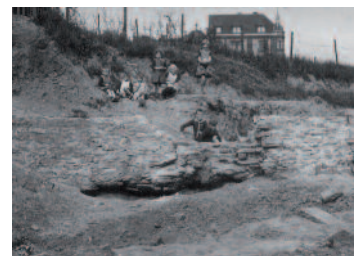
Weitere Mauern des Klosters in Duisern südlich des Duisernplatzes während der Freilegung 1924 Abb.22
