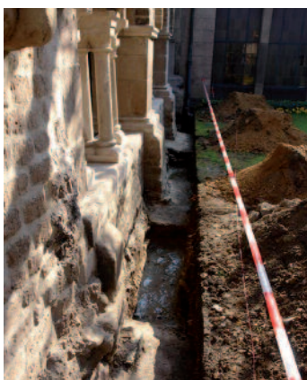
Arbeiten am Drainagegraben. Abb. 38
