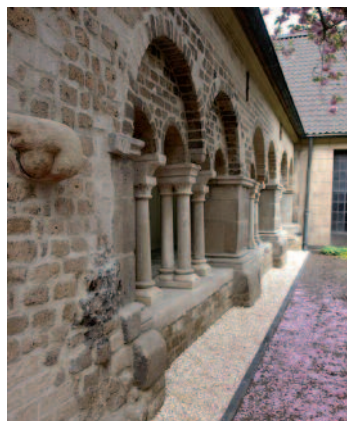
Die Kiesschüttung nach Fertigstellung. Abb. 39
