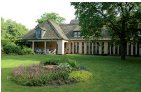
Blick vom Neubau in die bestehenden Klostergebäude, Ansicht von Norden. Abb. 52
