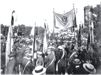
Abb. 18 Das Kaiser-Wilhelm-Denkmal wurde 1898 feierlich enthüllt.
