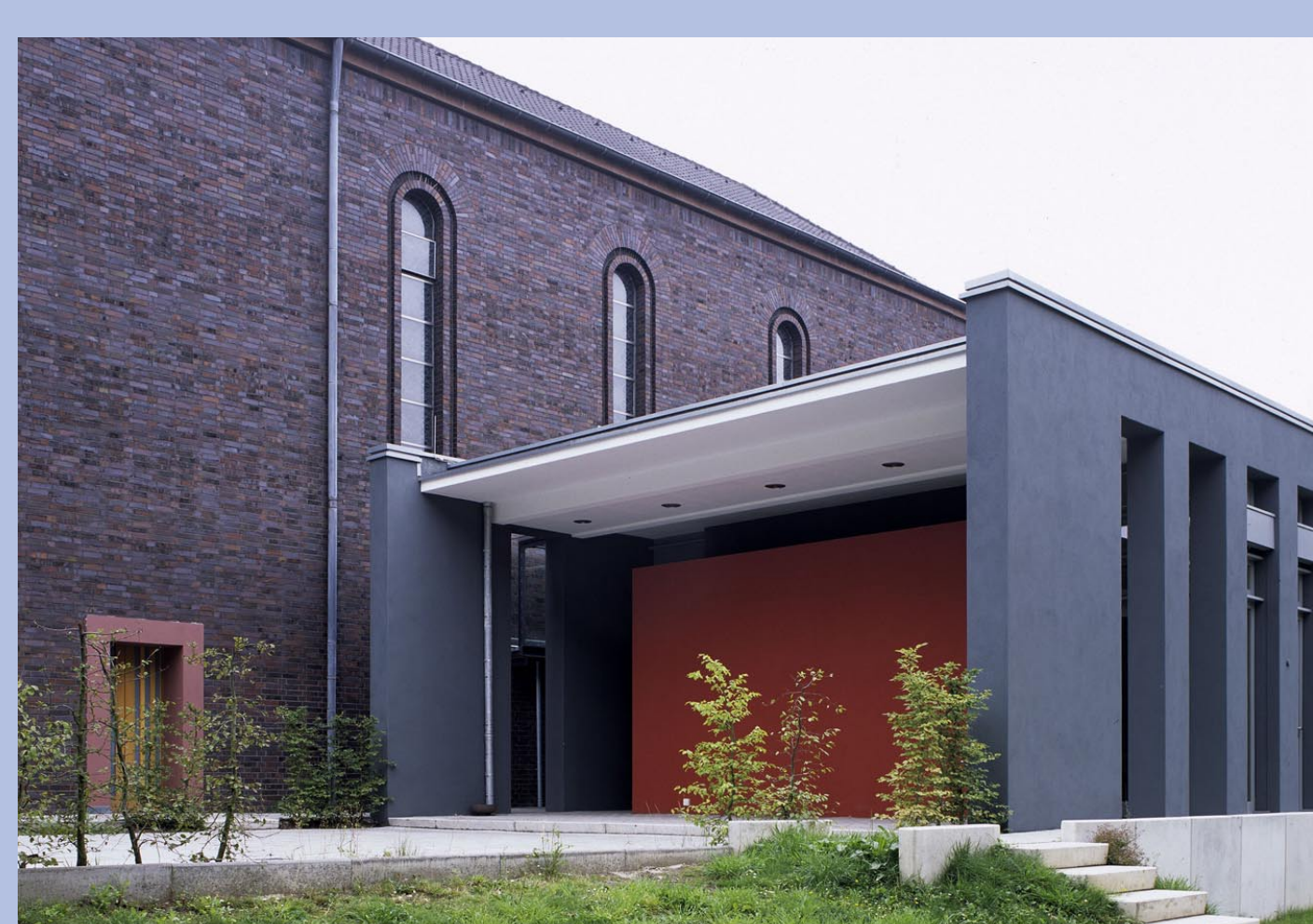
Erweiterungsbau Liebfrauenkirche Hochheide
