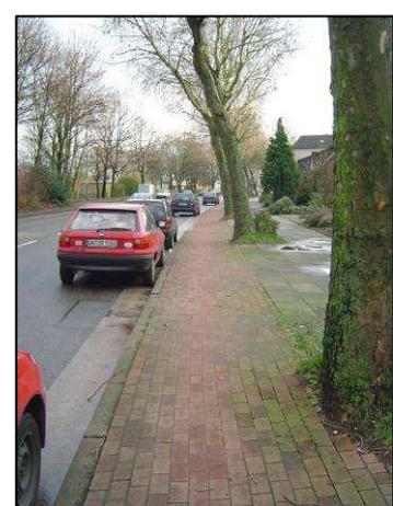
Abb. 36 Entfernung der Asphaltdecke, Neuverlegung von Pflaster (nachher).
