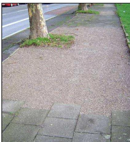
Abb. 34 Entnahme der Platten und Einbau von wassergeb. Material.
