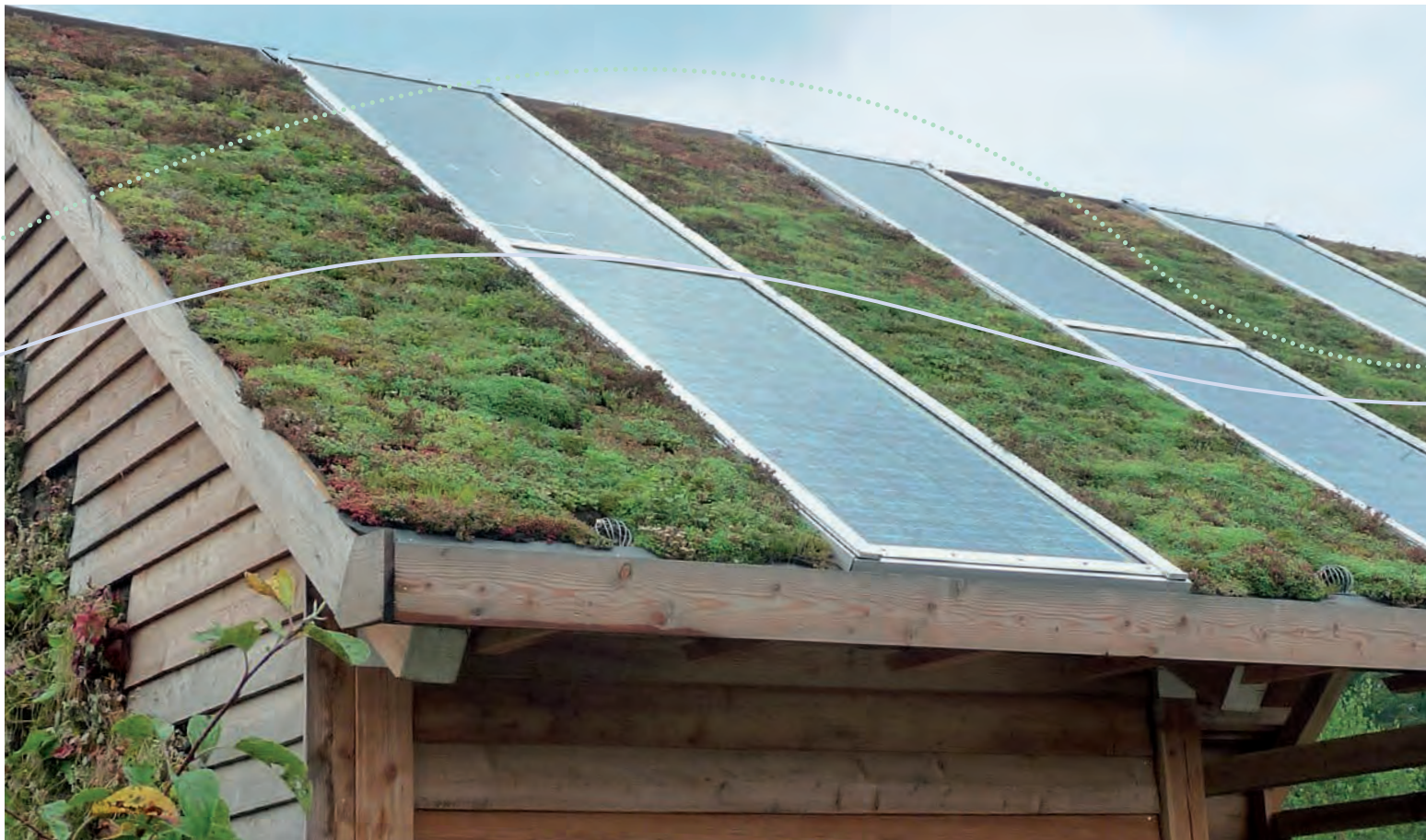
Begrünung kombiniert mit Photovoltaik
