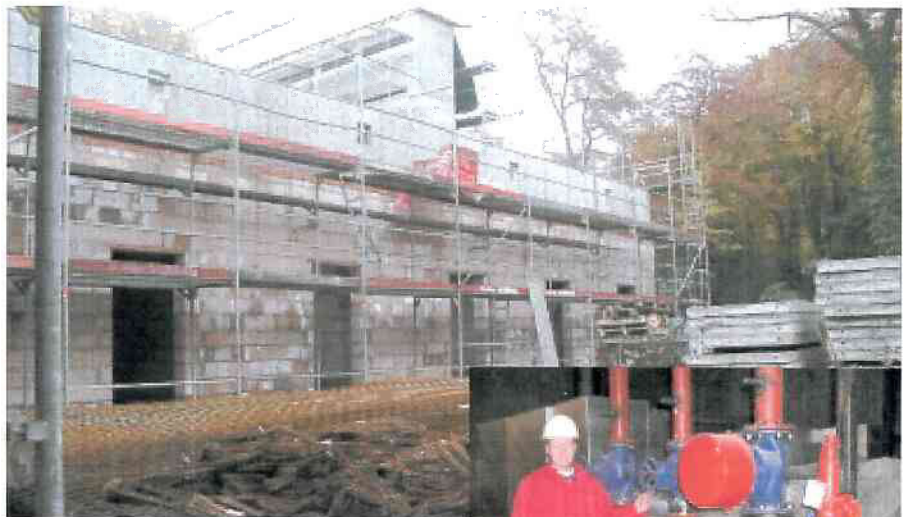
Seit März laufen die Bauarbeiten auf Hochtouren.
