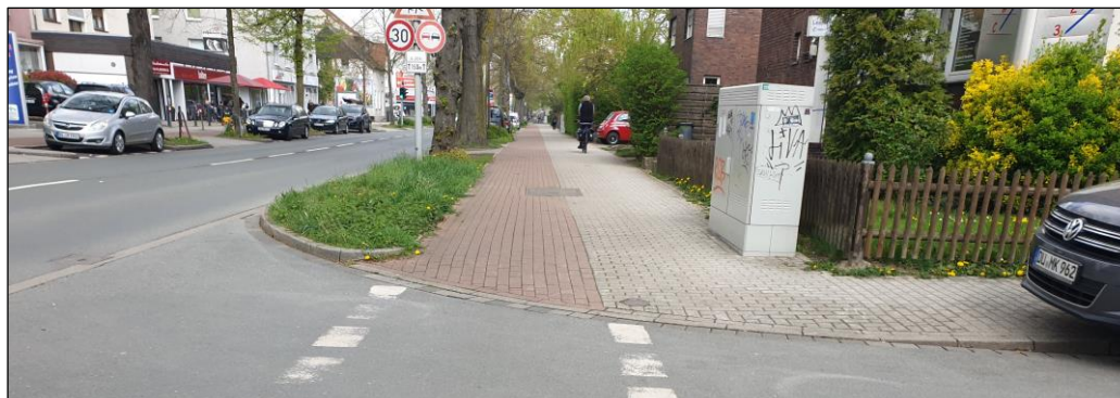
Abbildung 28: Duale Führung des Radverkehrs entlang der Großenbaumer Allee in Duisburg. Quelle: IGS Ingenieurgesellschaft Stolz GmbH.
