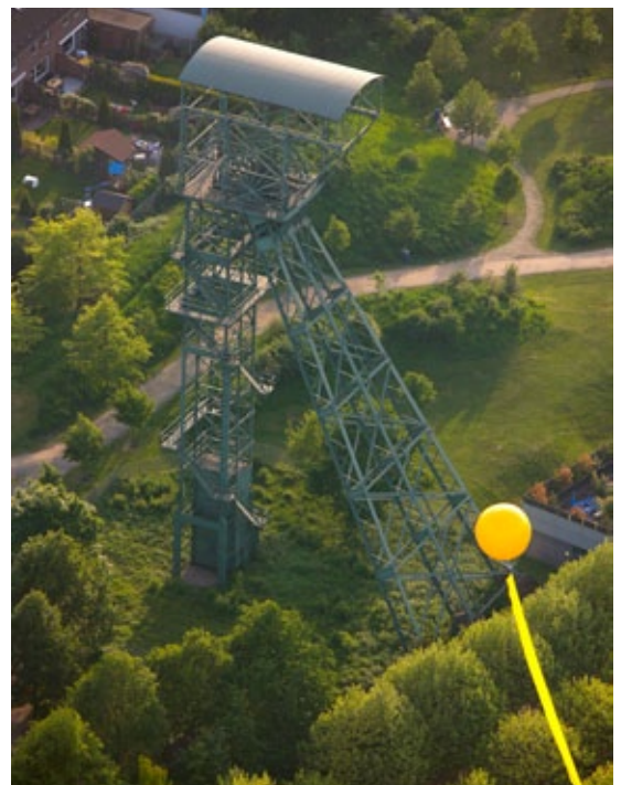
SchachtZeichen der Zeche Friedrich Thyssen 1/6
