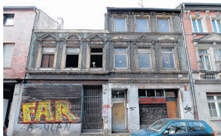
Diese Schrottimmobilen sollen als erstes verschwinden. FOTO: LARS FRÖHLICH
