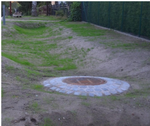
Abbildungen 79 & 80: Notüberläufe mit ordnungsgemäßem Abstand zur Muldensohle. Ausführung als Gitterrost (links) und als Überlaufrohr mit Tauchwandaufsatz (rechts)
