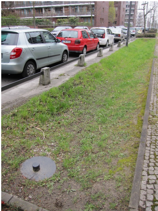
Abbildungen 48 & 49: Ableitung über die Schulter in straßenbegleitende Mulden. Intakte Grasnarbe durch Befahrungsbarrieren (links); deutliche Erosion des Oberbodens durch Befahrung (rechts)
