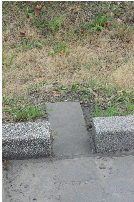
Abbildungen 50 & 51: Versagen der Ableitungsfunktion durch Ablagerungen in der Hochbordlücke (links); funktionsfähiger Einlauf durch Abschlussstein zwischen dem Hochbord (rechts)
