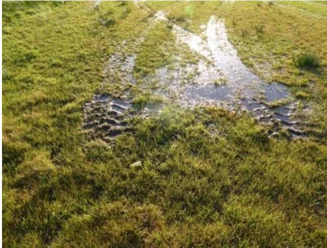
Abbildung 63: Verdichtete Fahrspuren als Ausgangspunkt für die Kolmation der Sickersohle
