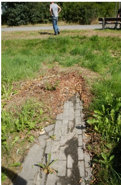
Abbildungen 41 & 42: Rinne im Straßennebenraum mit massiven Ablagerungen von Laub und Sediment (links) und ordnungsgemäße Rinne im Straßennebenraum mit Übergang zu Verrohrung (rechts)
