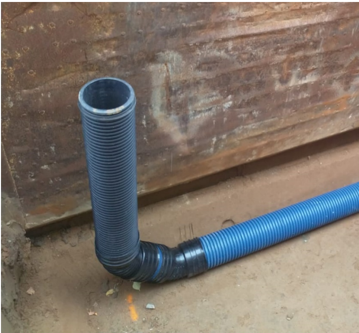
Abbildung 83: Verbindung von Dränrohr und Muldenüberlaufrohr beim Mulden-Rigolen-System vor Einbau des Rigolenkieses
