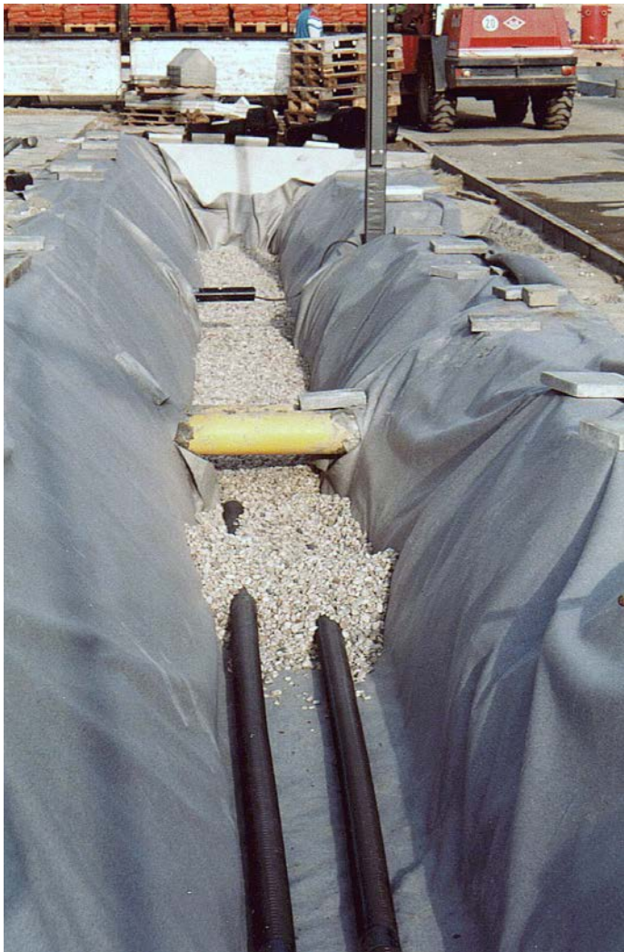
Abbildung 75: Einbringen des Geotextils unter Vorhaltung ausreichender Überlappungsbereiche
