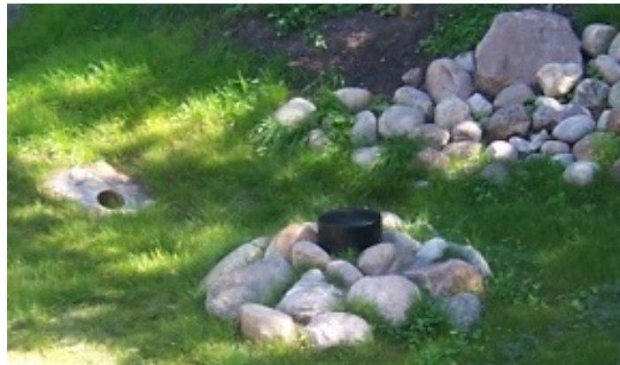
Abbildungen 79 & 80: Notüberläufe mit ordnungsgemäßem Abstand zur Muldensohle. Ausführung als Gitterrost (links) und als Überlaufrohr mit Tauchwandaufsatz (rechts)
