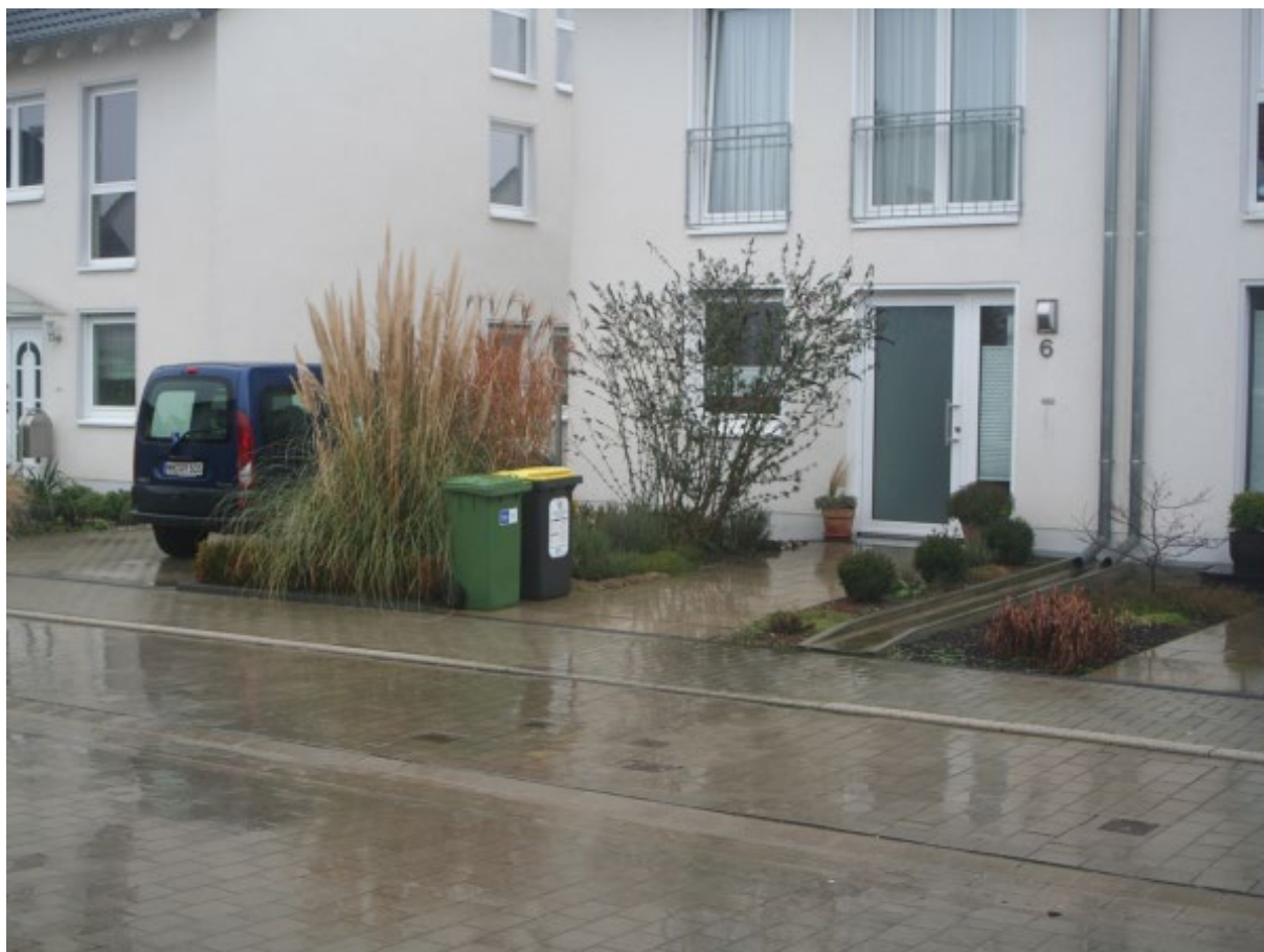
Abbildung 9: Offene Ableitung privater Dachabflüsse auf öffentliche Straße
