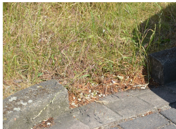
Abbildungen 53 & 54: Verkrautung punktueller Zuläufe (links) und aufgrund fehlender Abschlusssteine (rechts)
