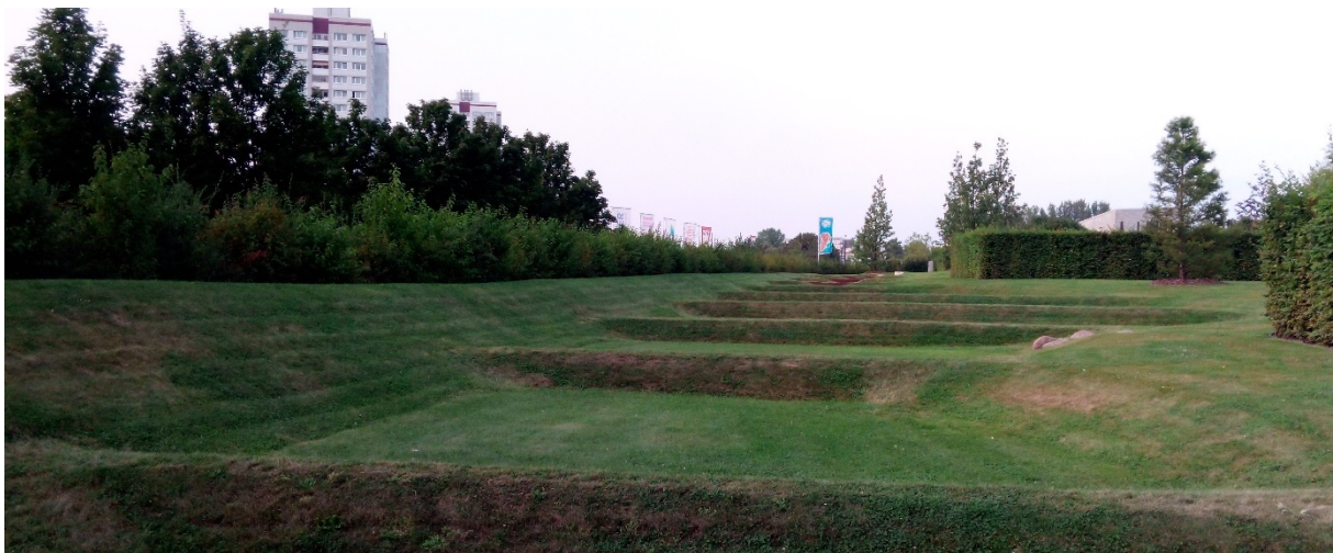
Abbildung 70: Kaskadenwälle einer landschaftsintegrierten Mulde. Initiale Erosionsspuren aufgrund der steilen Böschungsneigung in Verbindung mit geringer Wasserspeicherkapazität der verbauten Bodenarten.
