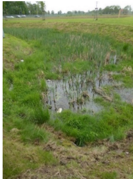
Abbildungen 67 & 68: Zerstörung der Muldensohle durch Befahren mit initialen Dauerstaubereichen (links), die langfristig zu einem kompletten Funktionsversagen der Muldensohle (rechts) führen können
