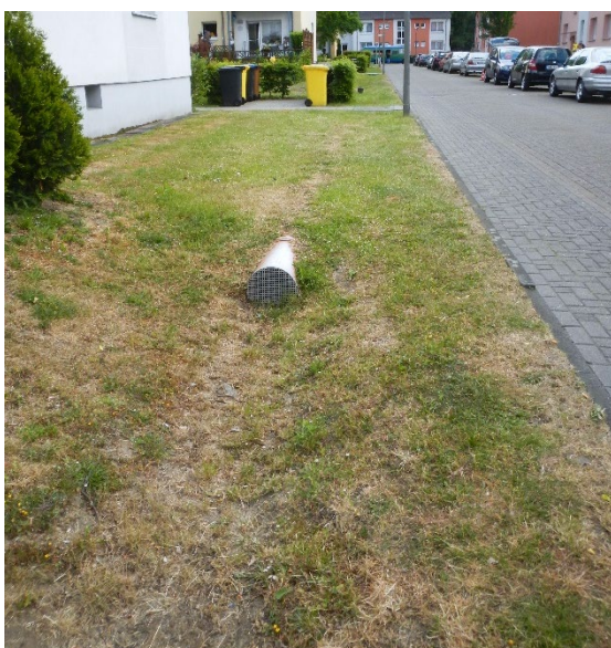
Abbildung 47: Offener Graben am Straßenrand im ordnungsgemäßen Pflegezustand (intakte Grasnarbe, kein Unrat/Laub). Große Nennweite der anschließenden Verrohrung schützt vor Frostsprengung
