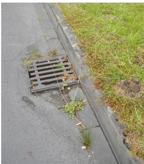
Abbildung 43: Konventionelle Bordrinne mit punktuelltem Ablauf in anschließende Mulde
