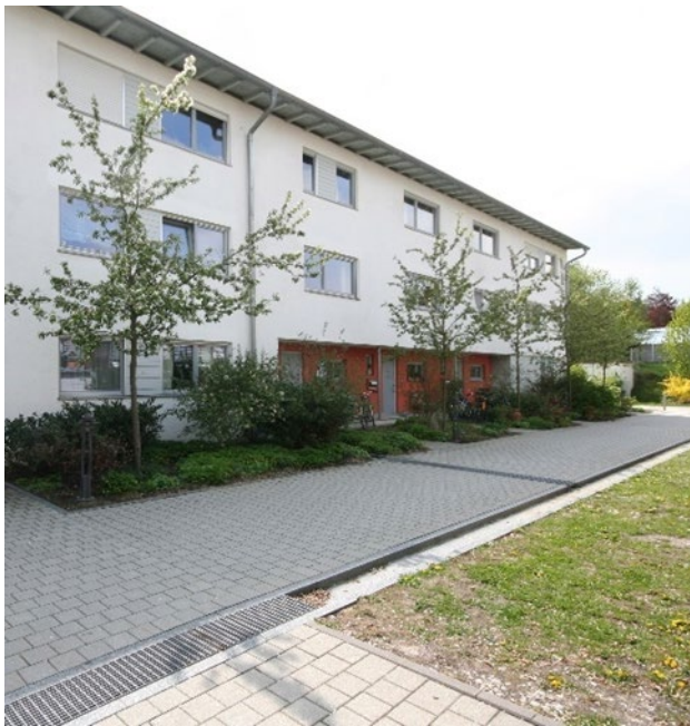
Abbildung 22: Beispiel für offene Kastenrinne als wegebegleitendes Sammel- und Transportmedium
