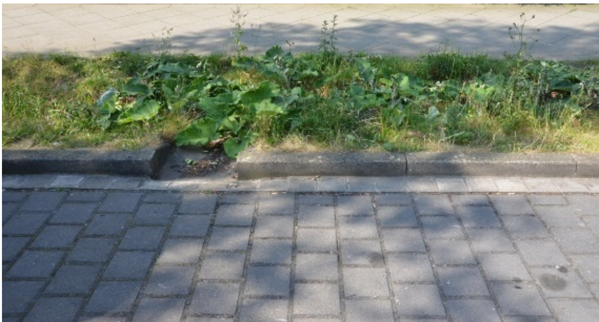
Abbildung 43: Konventionelle Bordrinne mit punktuelltem Ablauf in anschließende Mulde
