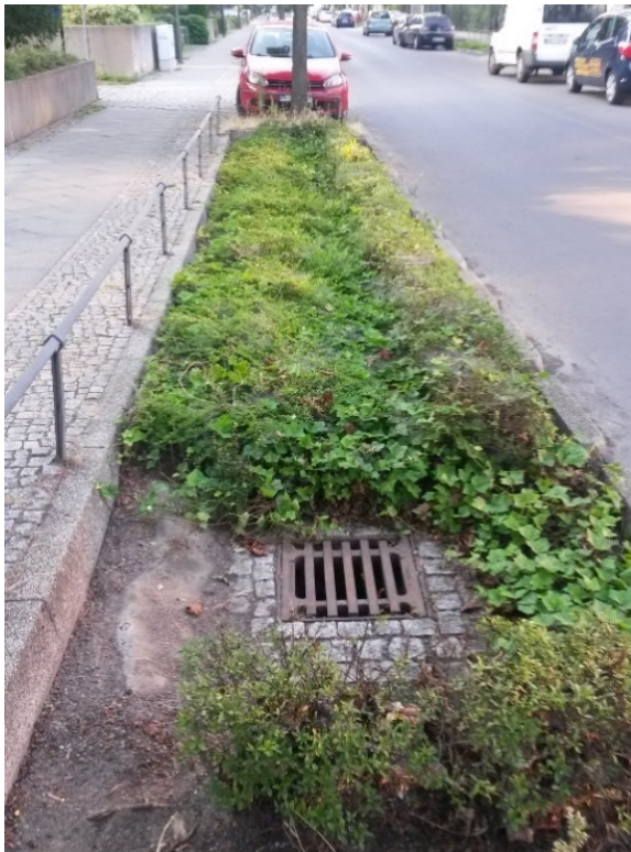
Abbildungen 81: Notüberläufe als Straßenablauf mit Anordnung auf der Muldensohle führen zu einem kompletten Wegfall der Retentions- und Filterfunktion
