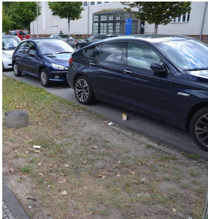
Abbildungen 48 & 49: Ableitung über die Schulter in straßenbegleitende Mulden. Intakte Grasnarbe durch Befahrungsbarrieren (links); deutliche Erosion des Oberbodens durch Befahrung (rechts)
