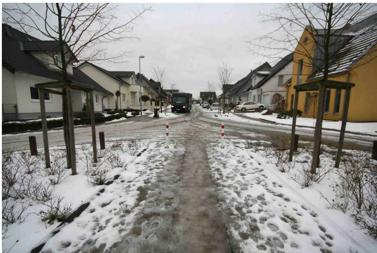
Abbildung 10: Offene Ableitung auch im Winter bei Schnee und Eis leistungsfähig
