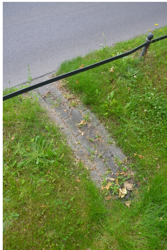
Abbildungen 55 & 56: Zulaufrinne zur Überwindung längerer Fließwege (links); Beispiel für ordnungsgemäß ausgeführte Pflasterrinne im Straßenbereich (rechts)
