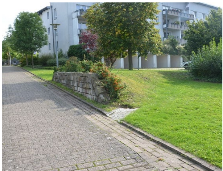
Abbildungen 31 & 32: Offene Rinnen als U-Profil mit starken Ablagerungen (links) und als eingefasster Stichbogen mit einsetzender Ausspülung von Fugen (rechts)
