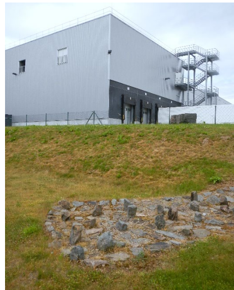
Abbildungen 56 & 57: Große Zulaufrinne mit rauen Wasserbausteinen in Gefällebereichen und glatten Muldensteinen in flachen Bereichen (links); breitflächige Zuleitung mit erfolgreich unterbundener Erosion durch Strömungsstörsteine (rechts)
