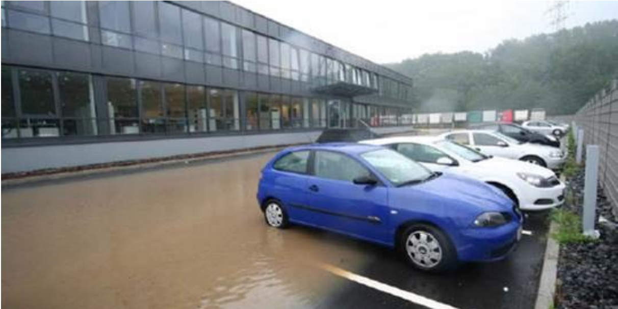
Abbildung 2: Schadloose Überflutung eines Grundstücks nach Starkregen
