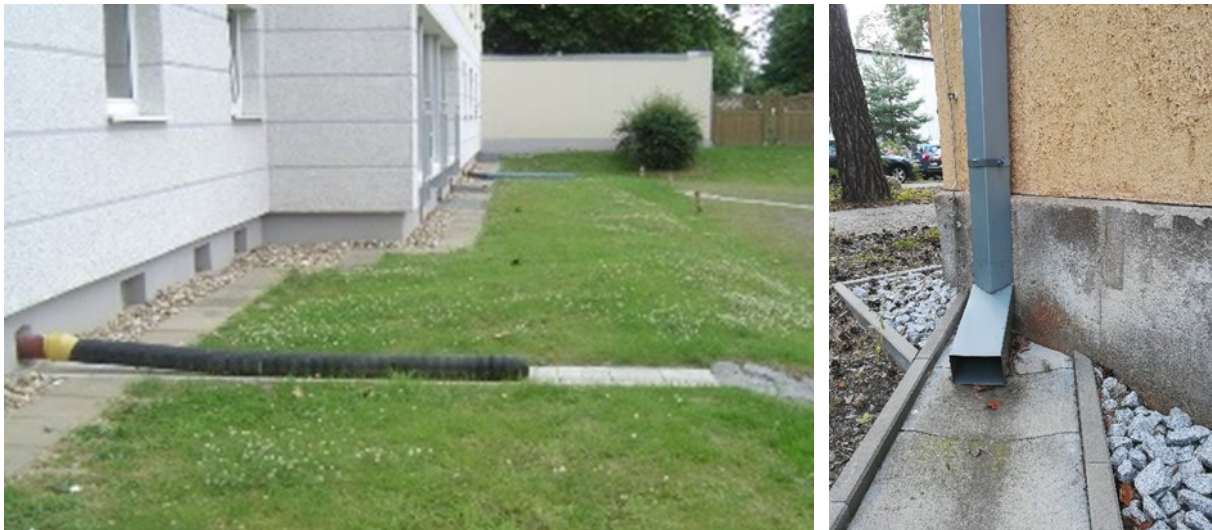
Abbildungen 29 & 30: Ordnungsgemäße Ausführung von Rohrvorstreckung, Rinnenelementen (Bild links/rechts) und Kolkchutz (Bild links)
