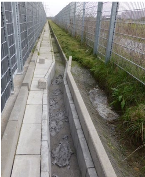
Abbildungen 31 & 32: Offene Rinnen als U-Profil mit starken Ablagerungen (links) und als eingefasster Stichbogen mit einsetzender Ausspülung von Fugen (rechts)
