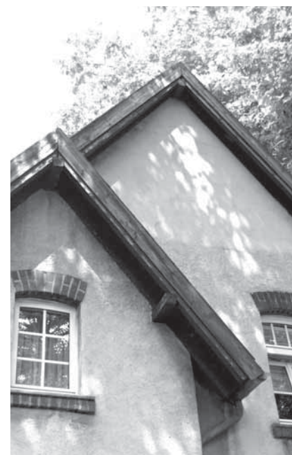
Dachabschluss im Giebelbereich mit hölzernem Ortgangbrett
