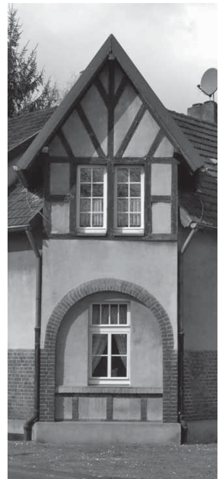
Giebelwand eines Wohnhauses in der Siedlung Bergmannsplatz
