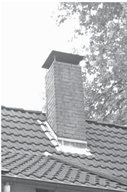
Positives Beispiel – ziegelsichtiger Schornstein mit Abdeckung (Meidinger Scheibe)
