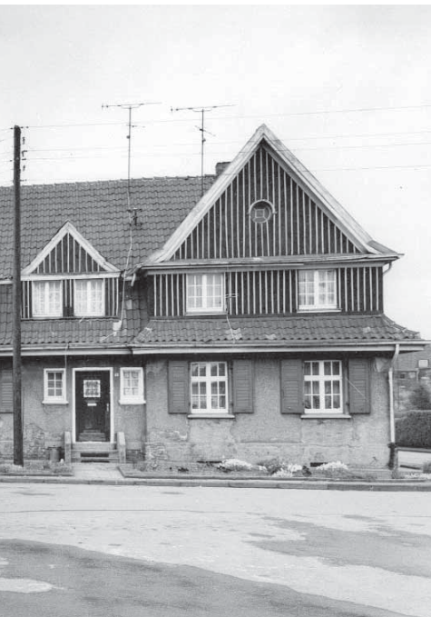
Historische Fensterteilung, Aufnahme 1972
