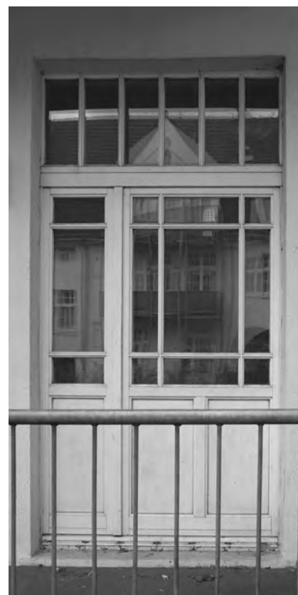
Links: Erneuerte Hauseingangstür Mitte: Erneuerte Hoftür Rechts: Erneuerte Balkontür
