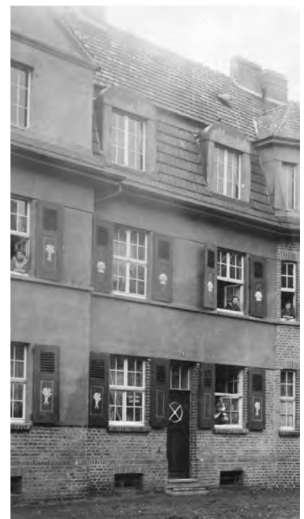
Links/Mitte: Sockel mit Sichtbetoneckquadern Rechts: Fassade mit Putz- und Ziegelflächen, historische Aufnahme (verm. 1920er Jahre)
