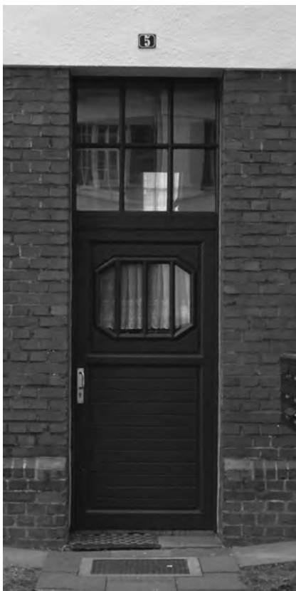
Erneuerte Hauseingangstüren der Siedlung Hüttenheim
