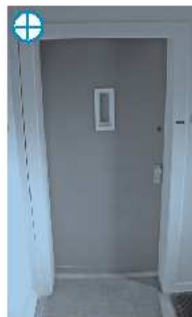
Positives Beispiel – historische Wohnungstür mit Fenster
