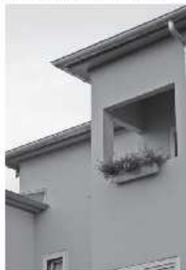
Aktuell vorhandener Dachüberstand
