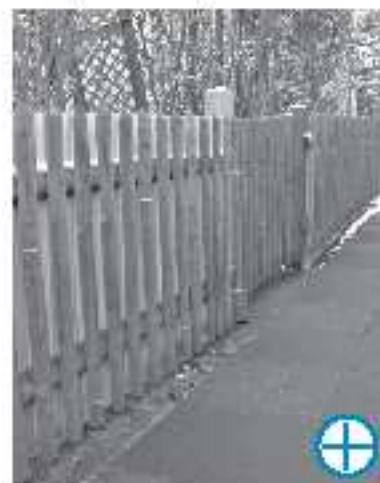
Positives Beispiel – Holzzaun mit vertikalen Stäben (zum Innenhof)
