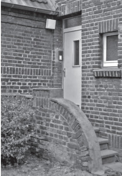
Oben: Gemauerte Wange mit abgerundeter Oberkante bei seitlichem Eingang Unten: Gemauerte Wange mit schräger Oberkante bei vorderem Eingang Rechts: Historischer Eingangsbereich mit Pergola in den 1920er Jahren
