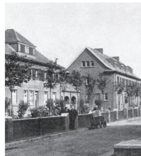
Dachlandschaft in den 1920er Jahren – historische Gauben
