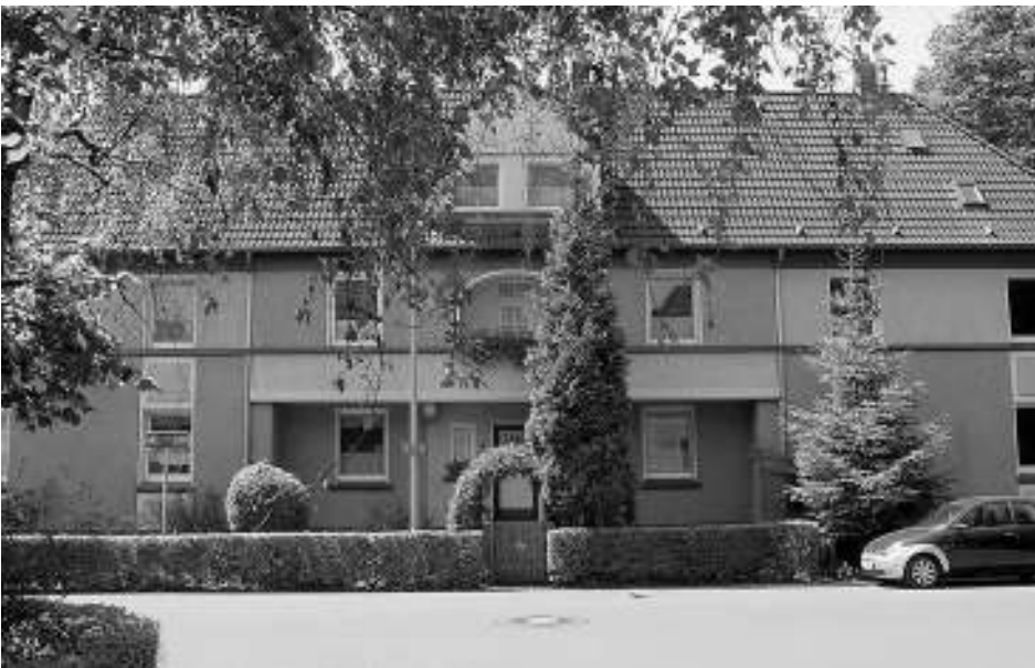
Loggia im Obergeschoss von Haustyp DED 1919, Platz an der Einmündung Waldlehne/Berglehne/Zum Ellenberg
