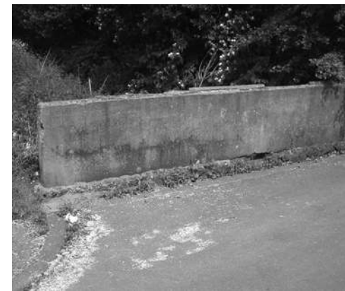
Oben: Brückengeländer über den Teichgraben an der Berglehne
