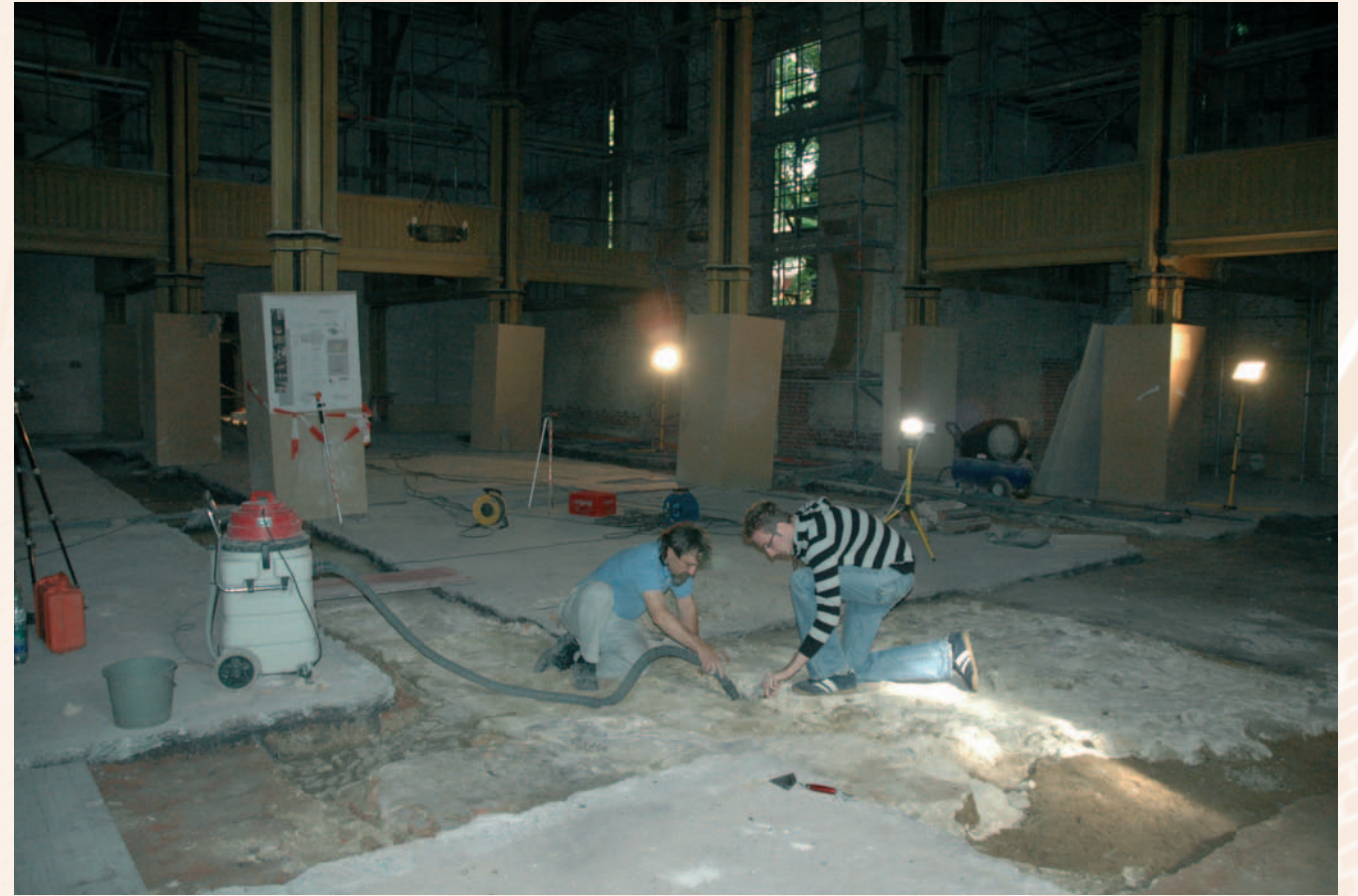
Freilegen der Kirchenfundamente durch die Stadtarchäologie Duisburg im Juni 2008
