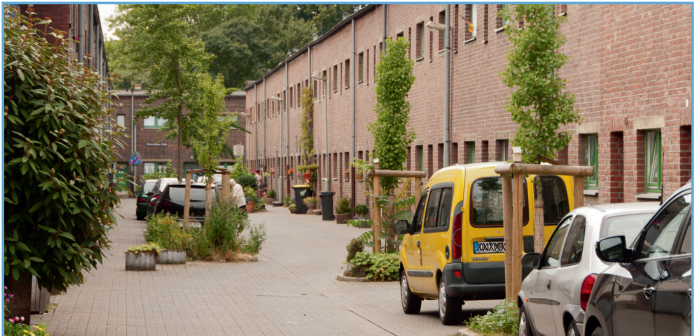
Abbildung 14: Dickelsbachsiedlung in Duisburg-Wanheimerort
