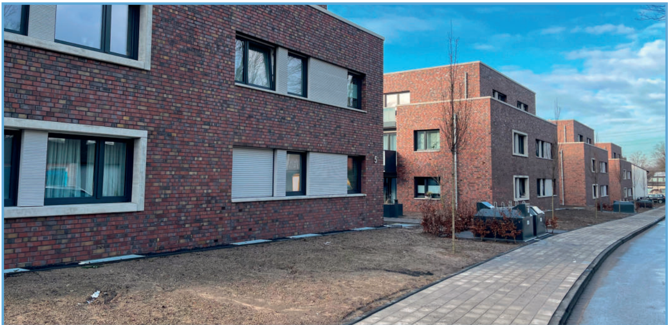
Abbildung 18: Baumaßnahme „Hettkampsweg“ im Ortsteil Röttgersbach
