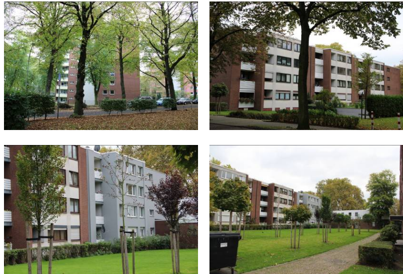
Abbildung 24: Moerser Straße 180 bis Husemannstraße 5, Fotos Stadt- und Regionalplanung Dr. Jansen GmbH, 2014
