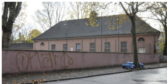
Eindrücke „Grundschule Hochfelder Markt“ | Quelle: EG DU 2020
