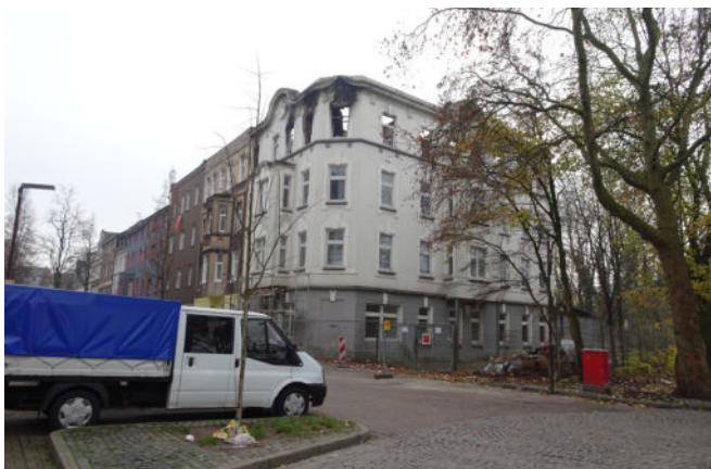
Beispiele für „Problemimmobilien“ in Hochfeld Quelle: cyclomedia 2019 / EG DU 2020 / Stadt Duisburg 2020
