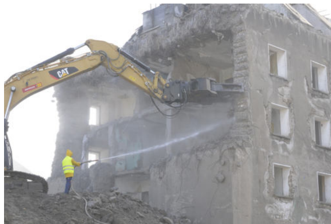
Abbildung 15: Abriss Bunker Hochfelder Markt Quelle: EG DU 2016
