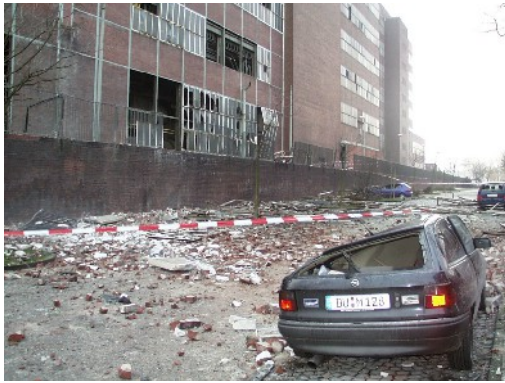
Kraftwerk, TKS, Laar
